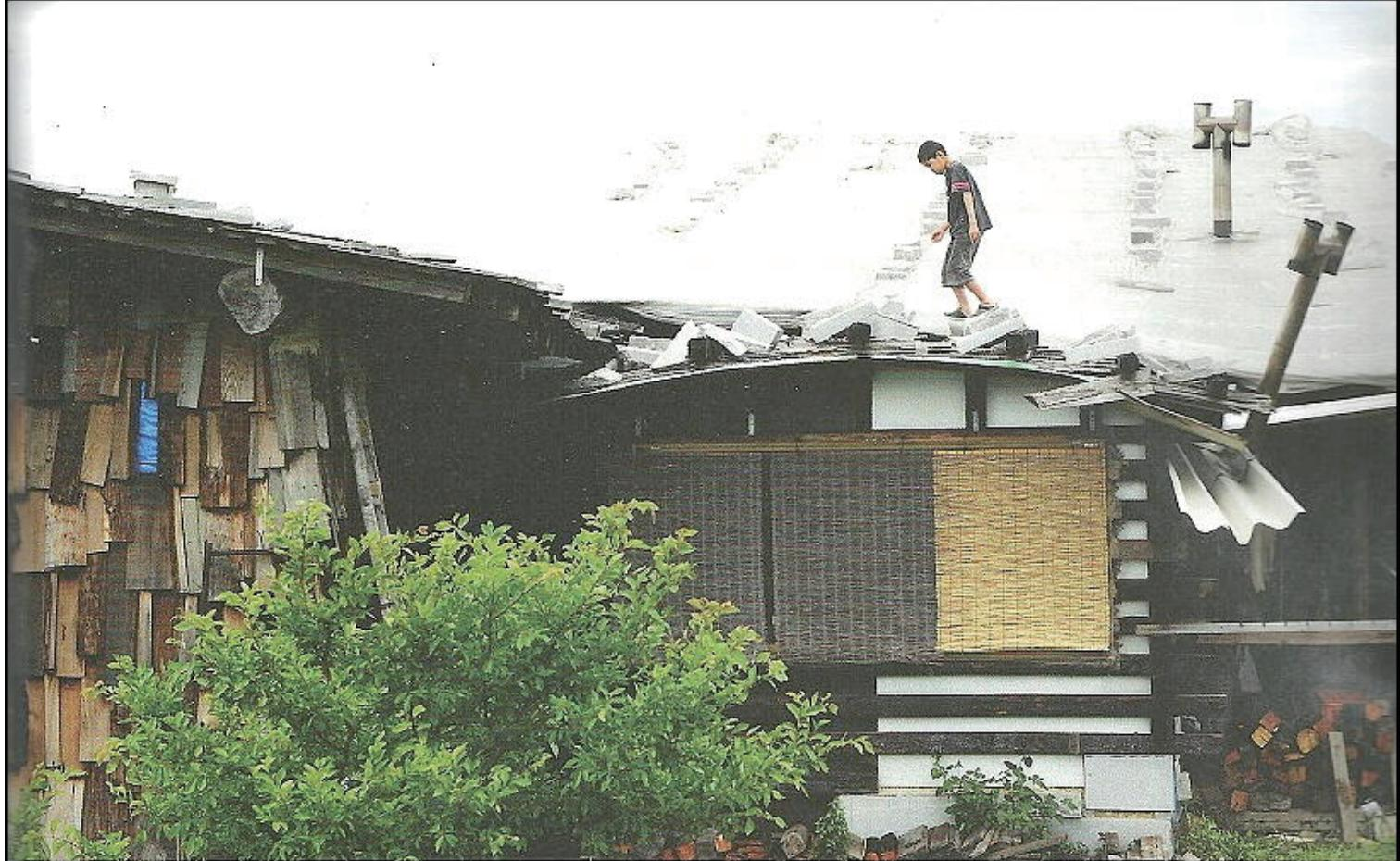
張り替え中の屋根には、レタスのトンネルに使われていた農業用ビニールハウスの廃材を重ねた。長さ100m以上もあるので棗ぎ目がなく、雨漏り対策も万全。重しには石や唐瓦を置いている
